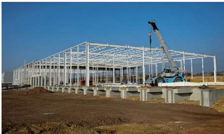
Figura 7.1 – Estrutura metálica para galpão.
